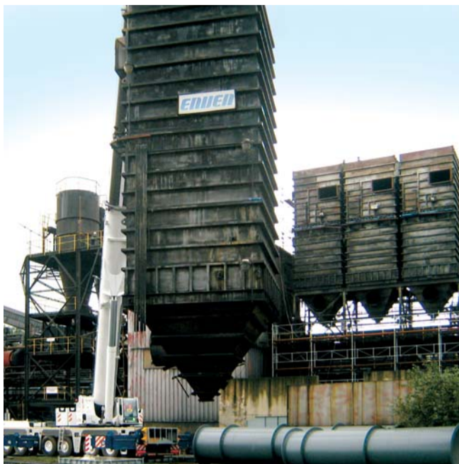
Demontáž stávajícího odprašovacího zařízení
