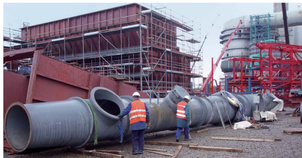
Příprava rozvodu primárního vzduchu k mlýnům
