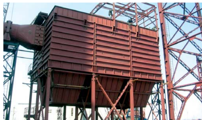
Instalace filtru EFP-6-5,5-260-D6 zóny spékání
