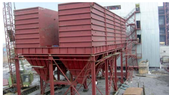
Instalace filtru EFP-8-5,5-352-D6 zóny chlazení
