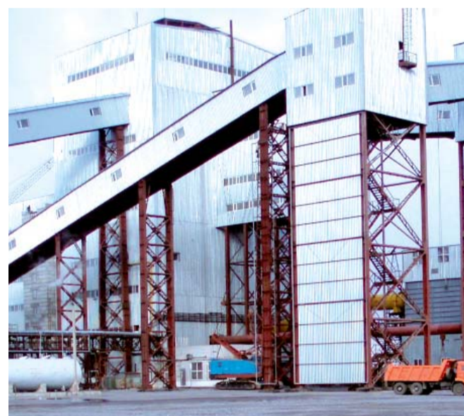
Celkový pohled na instalovanou technologii čištění plynů v Aksu
