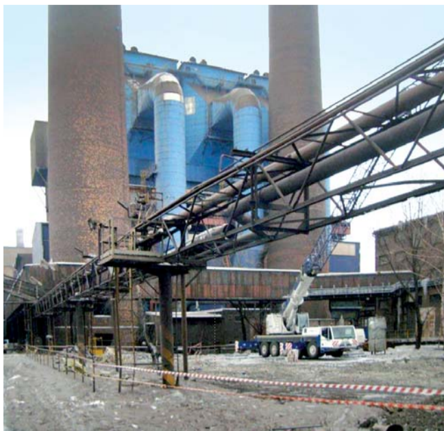
Staveniště před zahájením prací
