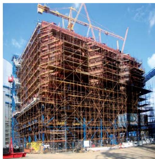
Montáž levého EO
