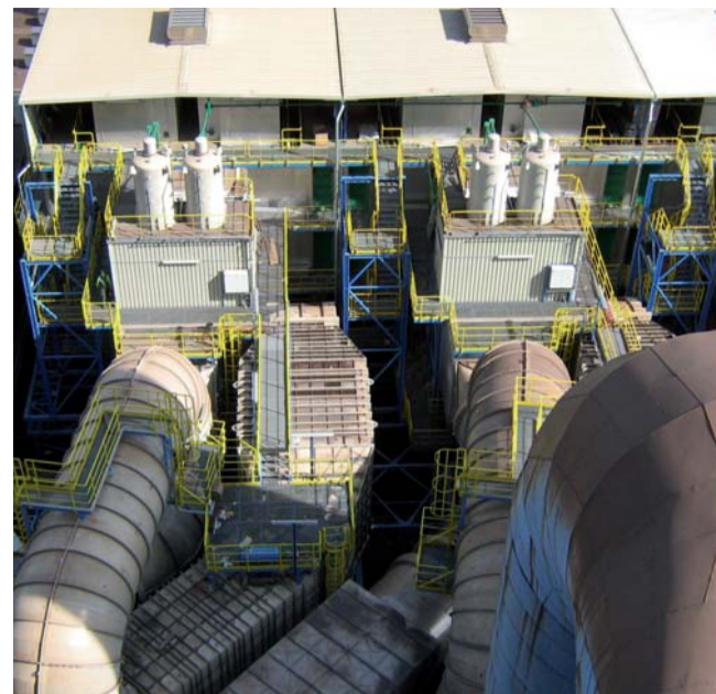
Dokončení montáže druhého stupně odlučování
