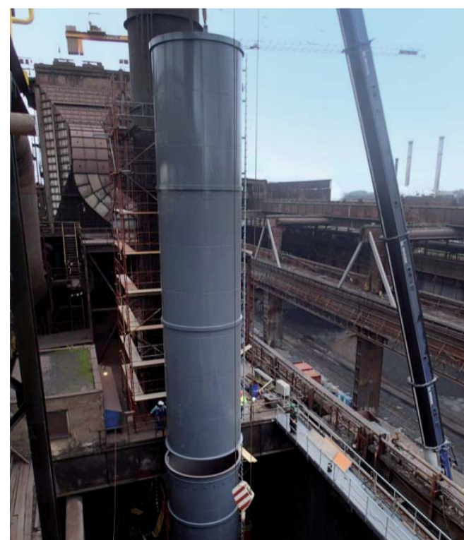
Montáž komínového výduchu VP4.
