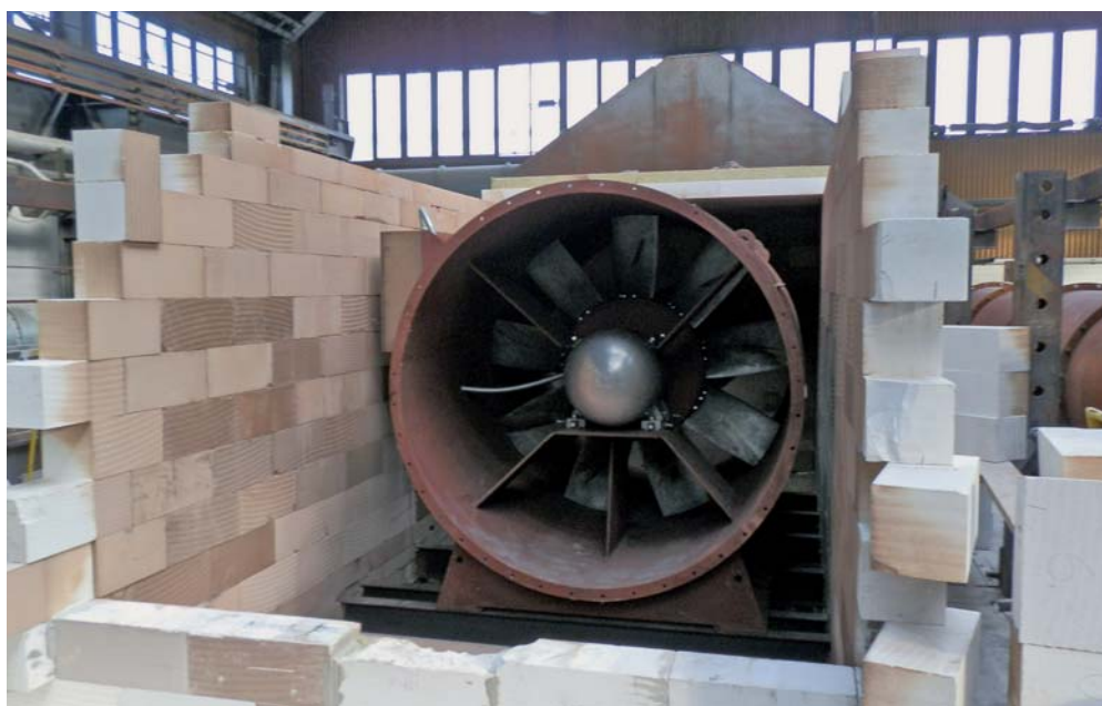
Ventilátor APWU 2240 / 1000min-1 umístěný v peci při výstavbě nadstavby pece
