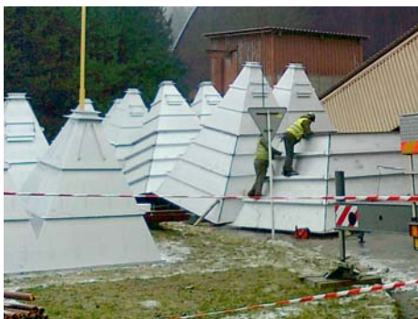
Předmontáž výsypek látkového filtru.
