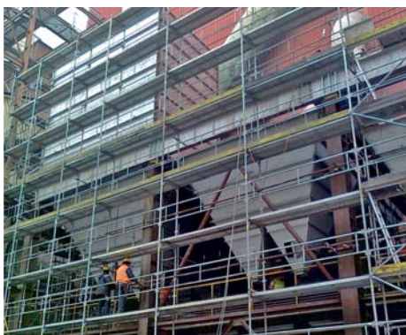
Montáž látkového filtru.
