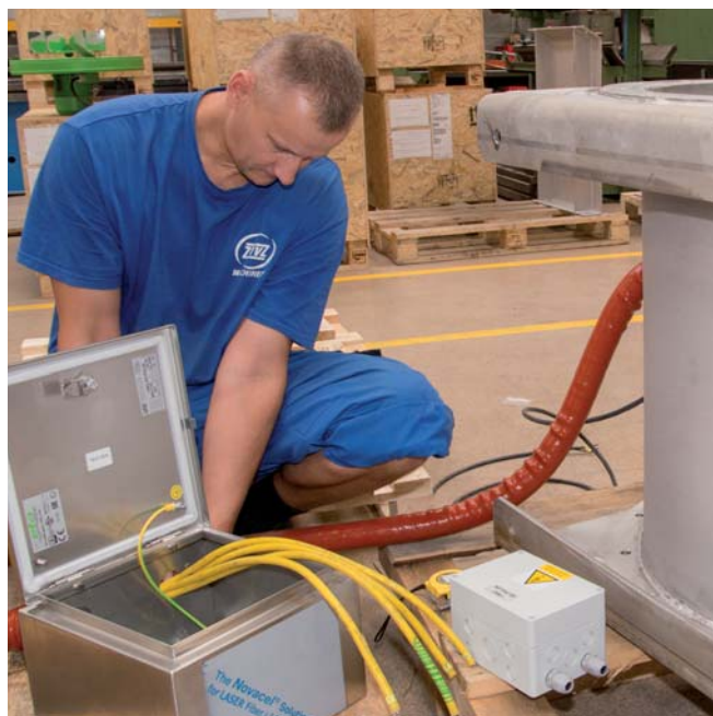
Luděk Rataj zajišťuje elektrické zapojení ventilátorů.
