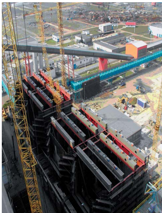
Rozpracovanost stavební části v Ledvicích 03/2010
