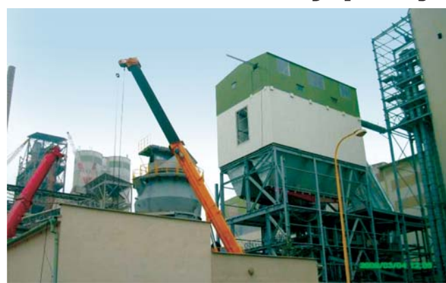
Látkový filtr s přírubou vstupního kanálu
