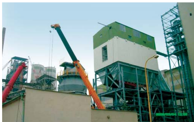
Látkový filtr s přírubou vstupního kanálu
