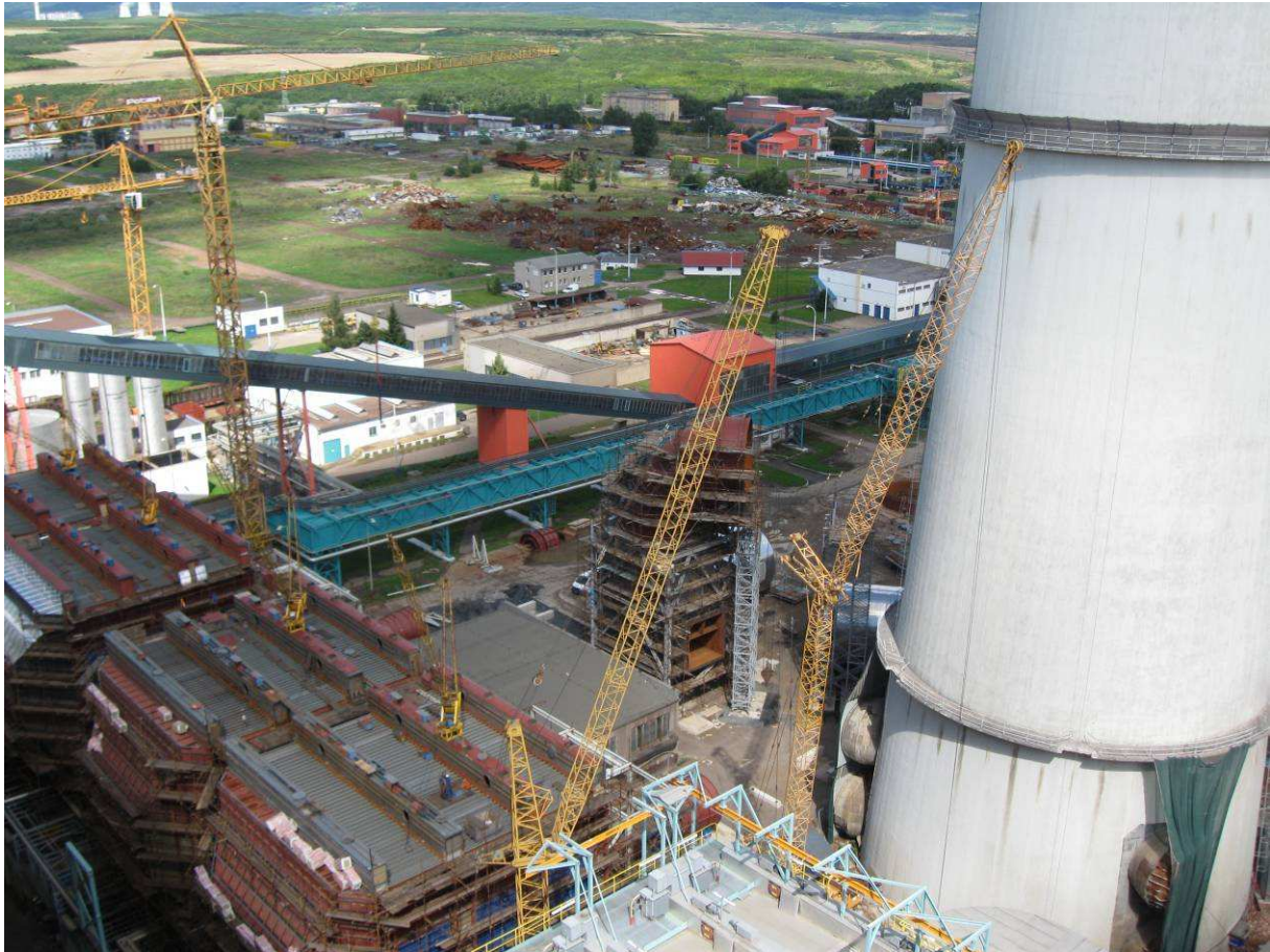
Obr. 5 - Průběh realizace KO ETUII, 2. etapa (bloky A, B)
