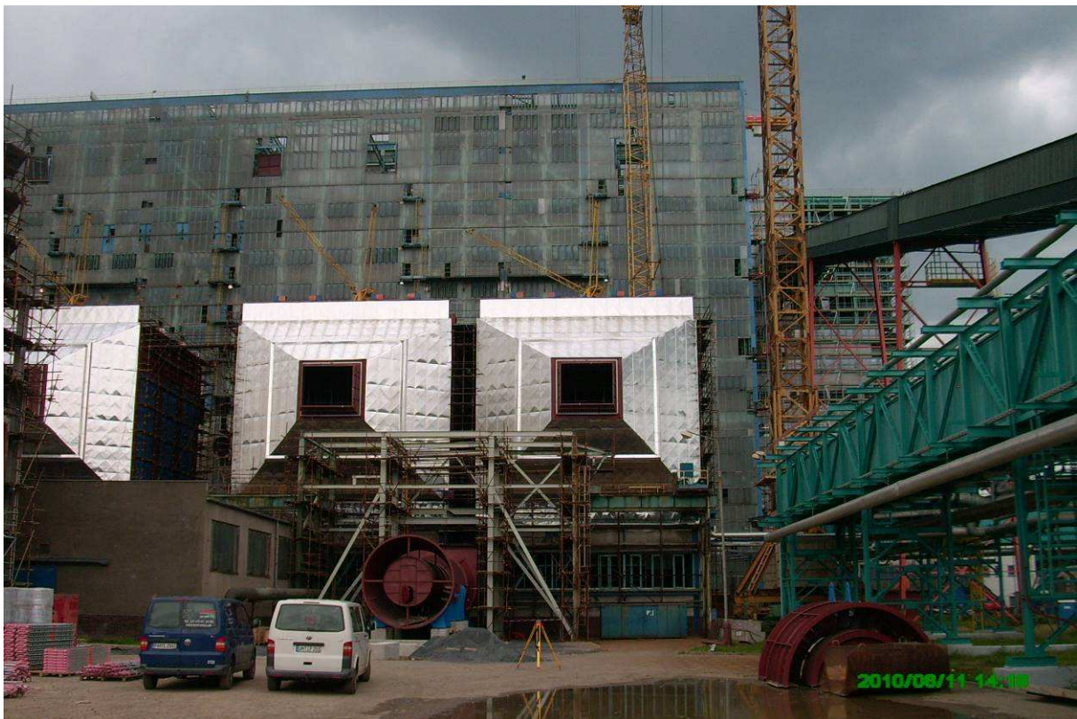
Obr. 6 - Průběh realizace KO ETUII, 2. etapa (bloky A, B)
